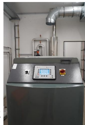
Blockheizkraftwerk
