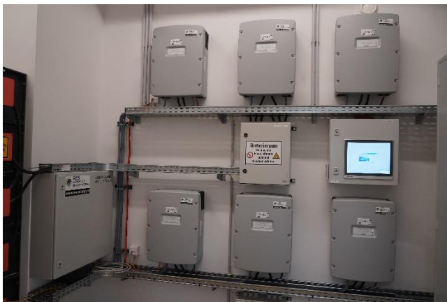
Wechselrichtersatz mit ECDS-Energiemanagementsystem
